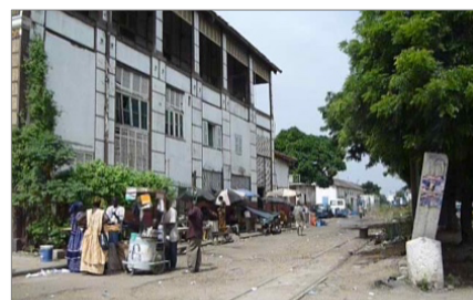
Photo 8- Mur oriental de la gare de Dakar en 2010 (Cliché J Varlet, 30/10/ 2010)
