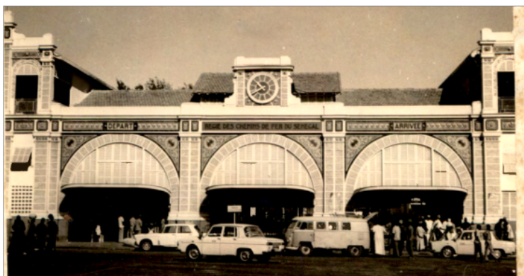
Photo 6- Façade de la gare de Dakar en 1971 (Source : extraite du mémoire de Pkakoum J., 1971)
