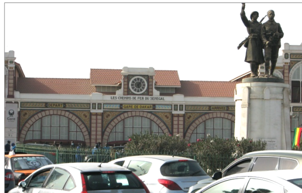
Photo 11- Façade de la gare de Dakar en 2022 (Cliché B.Lecoquierre, 22 avril 2022)
